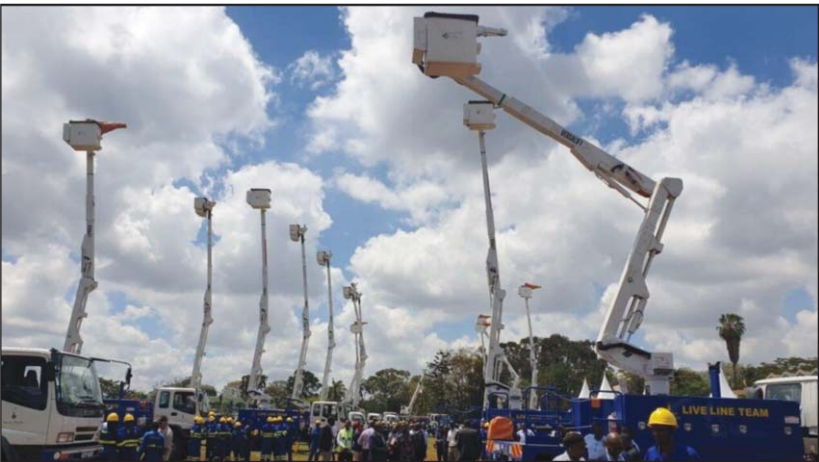
Nhiều công trình điện bị trì trệ trong những năm qua Ảnh: versaliftinternational
